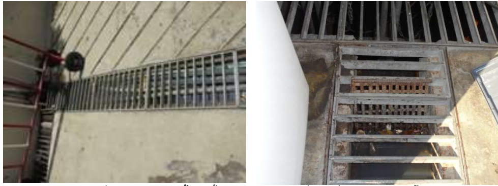
ภาพที่ 3-14 รางระบายน้ำ ติดตั้งตะแกรงดักขยะไว้เพิ่มเติมที่ปลายท่อ บ่อพักน้ำ
