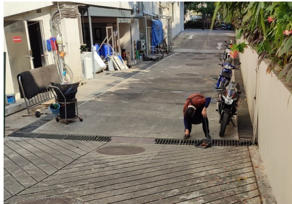
ภาพที่ 3-33 เก็บขยะที่อุดตันรางระบายน้ำ และทำความสะอาดรางระบายน้ำ
