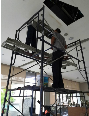
ภาพที่ 3-32 ทำความสะอาดเครื่องปรับอากาศภายในอาคาร
